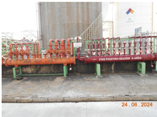
รูปที่ 1.8.3-4 ท่อดับเพลิง และ Air foam Header Zone 2: A- Area ที่มีการติดตั้งวาล์วเปิดม่านน้ำ Zone 2: A- Area
