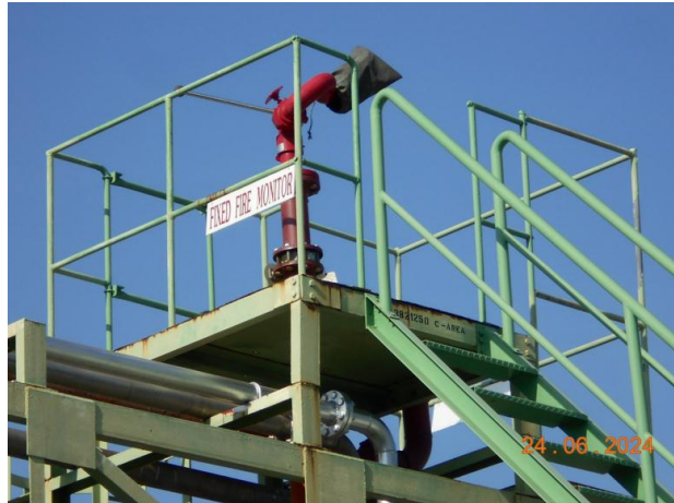
รูปที่ 1.8.3-7 หัวฉีดน้ำดับเพลิงที่ C- Area
