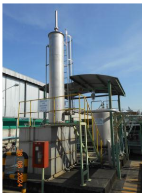
รูปที่ 2.4-5 สกรับเบอร์เพื่อดูดซับไอของสารเคมี
