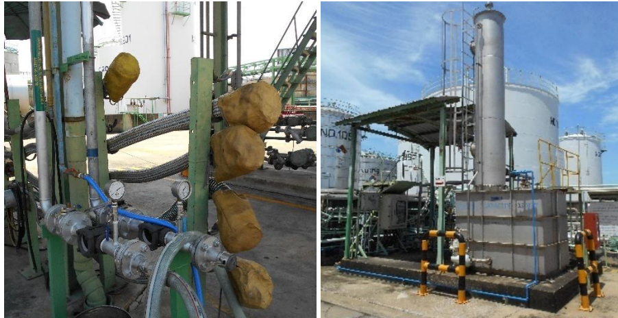
รูปที่ 1.16-6 ภาพ vapor line ที่ช่องโรงเดิมรถ TA.201 เพื่อนำไอระเหยสารเคมีเข้าสู่เครื่อง scrubber
