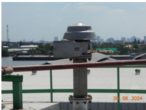
รูปที่ 2.4-1 ระบบควบคุมการระบายอากาศเข้า-ออก ภายในถังโดยติดตั้ง Automatic Breather Valve ซึ่งทำหน้าที่ปรับความดันภายในถังและนอกถังให้อยู่ในสภาวะสมดุล
