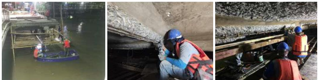
รูปที่ 1.16-2 ภาพซ่อมแซมโครงสร้างคอนกรีตบริเวณหน้าท่าเรือ BKK11
