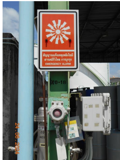
รูปที่ 1.8.3-16 สัญญาณแจ้งเหตุฉุกเฉิน ที่โรงเก็บถังใหม่ติดกับ F- Area
