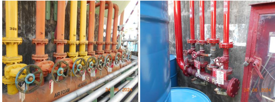
รูปที่ 1.8.3-11 ท่อดับเพลิง และ Air foam Header Zone 5 : D – Area
