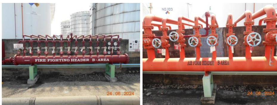
รูปที่ 1.8.3-9 (ซ้าย) ท่อดับเพลิง และ (ขวา) Air foam Header Zone 4 : B- Area
