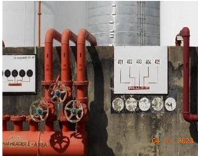
รูปที่ 1.8.3-13 ท่อดับเพลิง และ Air foam Header Zone 6 : E-Area
